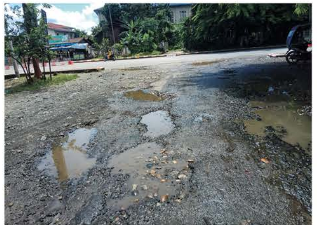
သီတာရပ်ကွက် ယခင်ကားကြီးကွင်း ဟောင်း အဝင်လမ်း
